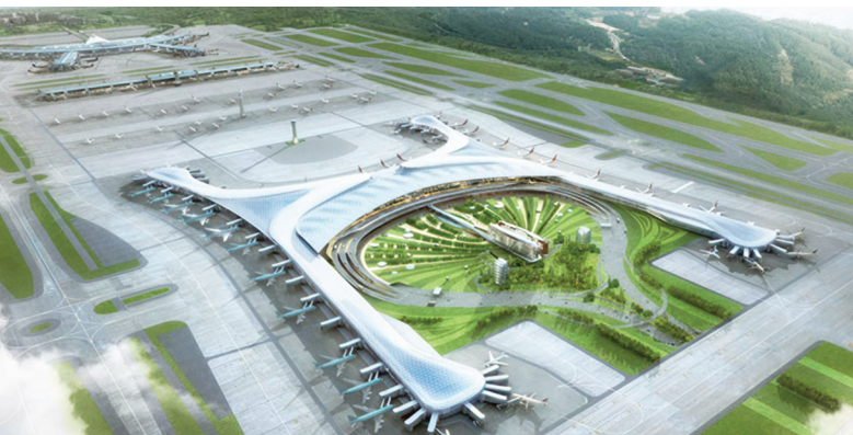
Situé à Bishoftu, à 45 km d'Addis-Abeba, le méga-aéroport doit permettre l'accueil de 110 millions de passagers par an. © Ethiopian Airlines.
